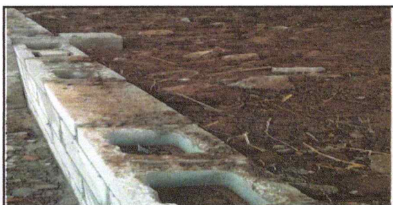
Foto 5: SE OBSERVA INICIO DE MURO DE BLOCK Y MALLA
