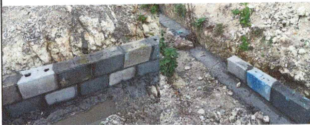
Foto 1: REPARACION DE MUROS DE CONTENCION
