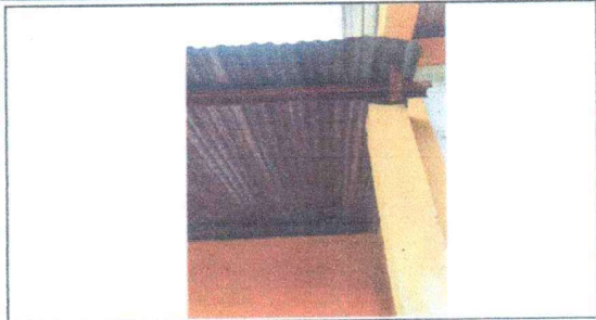
Foto 2: SUSTITUCIÓN ESTRUCTURA DE TECHO
