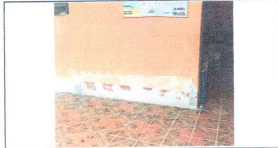
Foto 4: SUSTITUCION DE PINTURA BASE ACEITE (ZOCALO)
