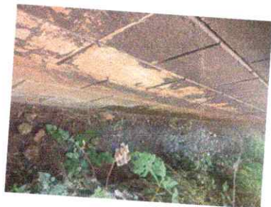
Foto 3: CANALETA FUNDIDA EN LOSA DE PATIO
