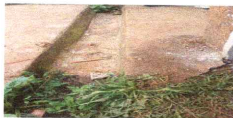
Foto 4: FUNDICIÓN DE LOZA DE PATIO
