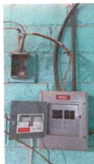
Foto 4 REPARACION DEL SISTEMA ELECTRICO
