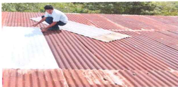
Foto1: SUSTITUCION DE ESTRUCTURA Y LAMINA TROQUELADA (calibre26)
