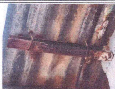
Foto 2: SUSTITUCIÓN ESTRUCTURA DE TECHO
