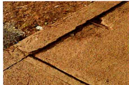
Foto 6: Sustitución de torta de concreto
