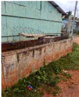
Foto 5: Sustitución muro perimetral
