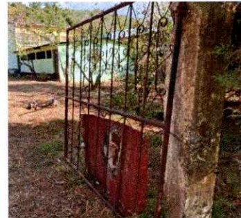
Foto 4: Sustitución de portones
