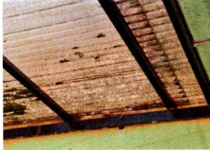
Foto1: Estructura de techo
