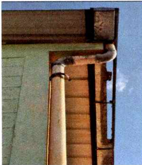
Foto 3: Sustitución de canales de metal
