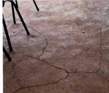
Foto 2: Sustitución torta de cemento
