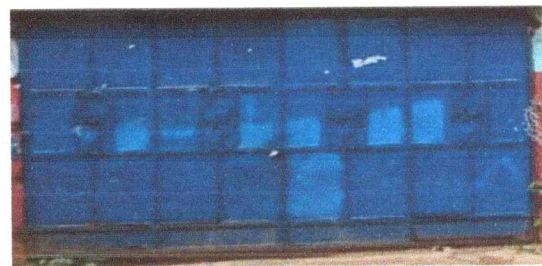
Foto 5: Sustrucción de porton principal de tubo con lámina lisa, (promedio 3x2mts.)
