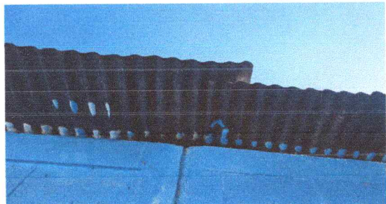
Foto 1: Sustrucción lámina troquelada calibre 26.
