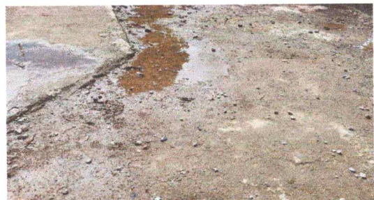
Foto 3: Sustrucción losa de patio, incluye base, fundición y acabado.
