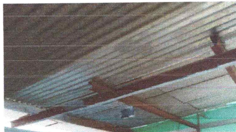
Foto 2: Sustrucción estructura de techo.
