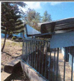
Foto 3: SUSTITUCIÓN DE CANALES Y BAJADAS 4"
