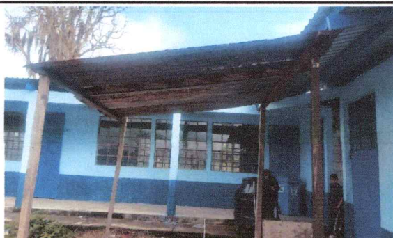
Foto 1: SUSTITUCIÓN LAMINA TROQUELADA CALIBRE 26
