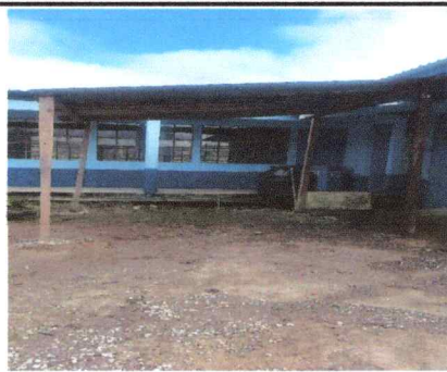
Foto 2: SUSTITUCIÓN ESTRUCTURA DE TECHO
