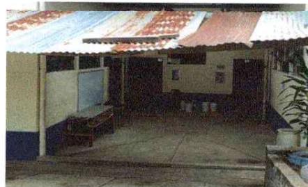
Foto 4: Sustitucion de lamina troquelada calibre 26, tubos galvanizados y costanera (12.30x7)
