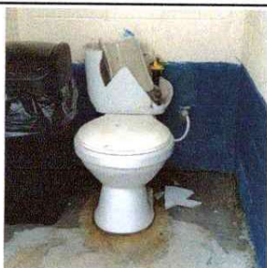
Foto 3: sustitucion de baños completos (incluye contra llave)
