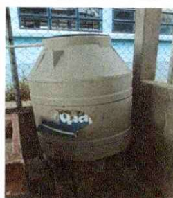
Foto 6 : plataforma de cisterna
