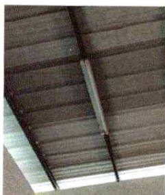
Foto1:sustitución de lamparas y plafoneras
