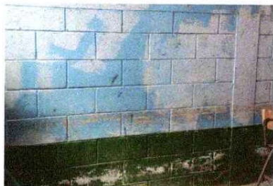
Foto 5: sustitución de pintura de agua y sustitución de pintura de aceite zocalo
