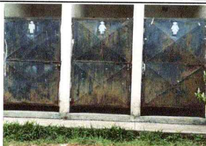
Foto 2: Reparación y Mantenimiento de puertas de baños
