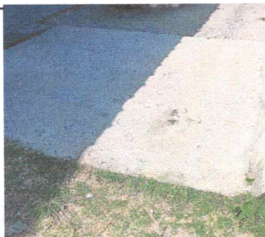
Foto 3: LOSA DE PATIO
