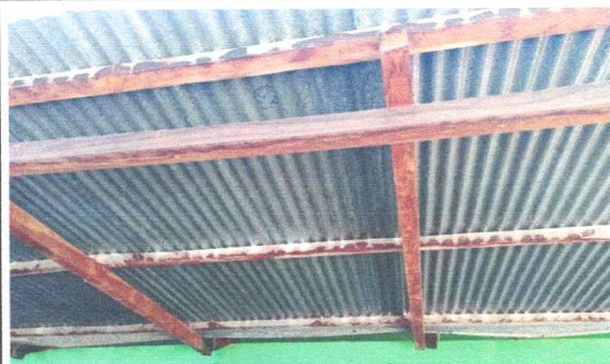
Foto1: CUBIERTA DE LAMINA Y ESTRUCTURA DE TECHO
