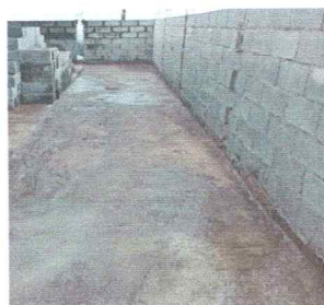
Foto 4: REPARACION DE MUROS DE CONTENCIÓN
