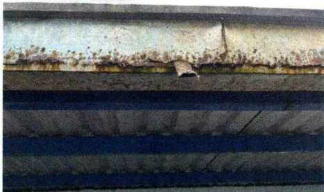
Foto 1: SUSTITUCIÓN DE CANALES Y BAJADAS 4"
