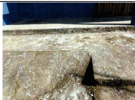
Foto 2: SUSTITUCIÓN LOSA DE PATIO INCLUY BASE, FUNDICION Y ACABADO
