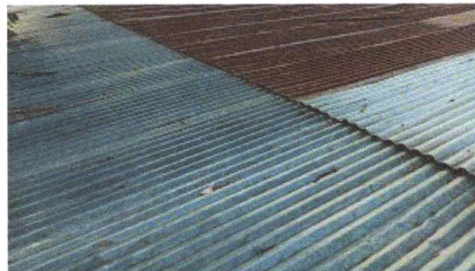
Foto 2: CUBIERTA DE LAMINA
