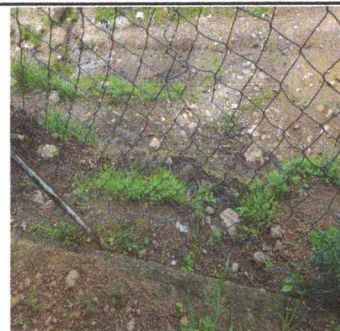
Foto 4: CERCO O MURO PERIMETRAL
