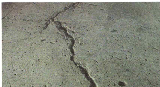
Foto1: LOSA DE PATIO
