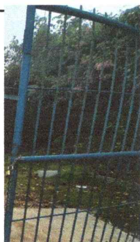
Foto 5: MANTENIMIENTO A PORTONES
