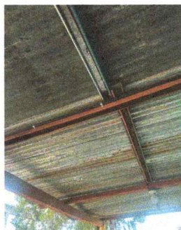
Foto 3: ESTRUCTURA DE TECHO
