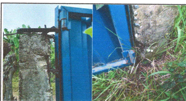
Foto 4: EVIDENCIA DE SOPORTES DE PORTON DETERIORADOS
