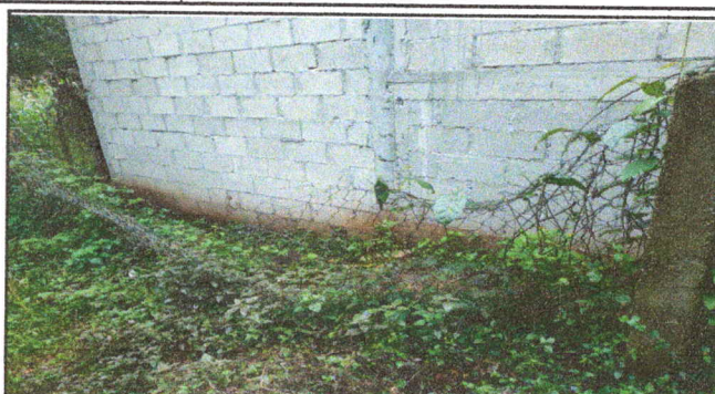
Foto 2: EVIDENCIA DE CERCO DE MALLA DESTRUIDO.
