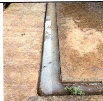
Foto 4: SUSTITUCION DE RED DE DRENAJES PVC4" INCLUYE ACCESORIOS
