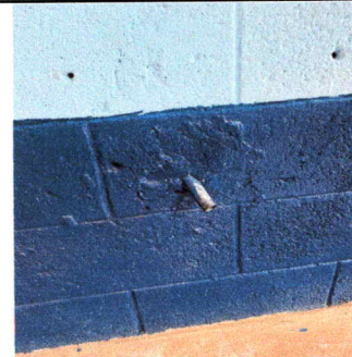
Foto 6: SUSTITUCION DE TOMACORRIENTE
