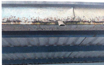
Foto 2: SUSTITUCIÓN DE CANALES Y BAJADAS 4"
