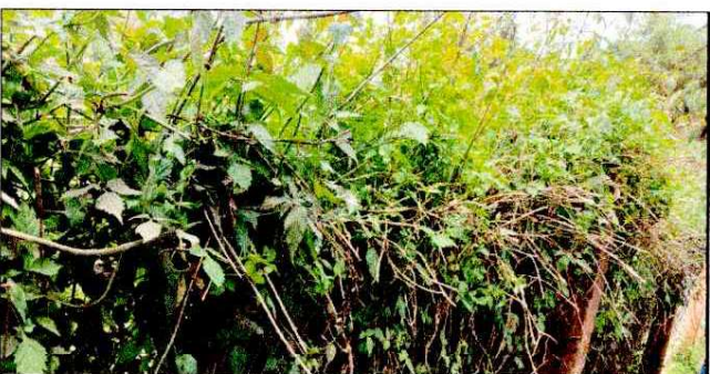
Foto 5: INGRESA DEMASIADO MONTE A LA ESCUELA, DEBIDO A LOS ARBOLES QUE HAY EN LA VECINDAD Y VENCIERON EL MURO,
