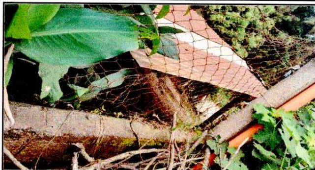
Foto 1: SE OBSERVA PARTE DEL MURO CON MALLA
