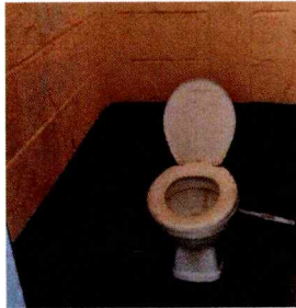
Cambio de Baños por mal Estado.
