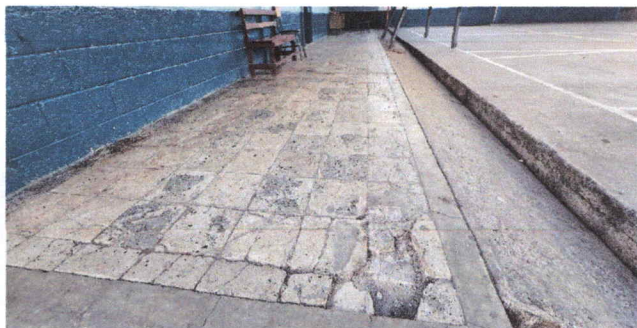
Foto 1: SUSTITUCION DE PISO
