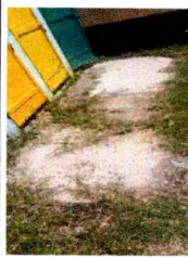
Foto 1: Sustrucción de losa de patio
