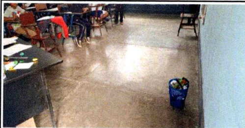
Foto 3: Sustrucción de piso
