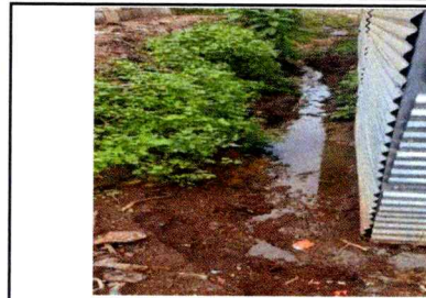
Foto 2: Sustrucción de red de drenajes
