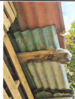
Foto 4: SUSTITUCION ESTRUCTURA DE TECHO
