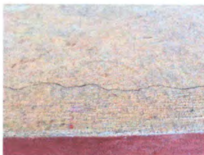
Foto 5: SUSTITUCION PISO CERAMICO
