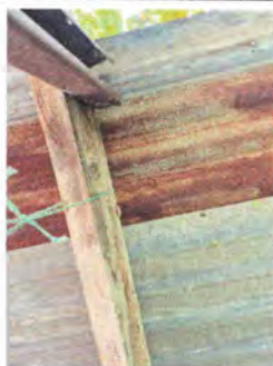
Foto 3: SUSTITUCION DE LAMINA
