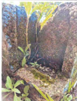
Foto 1: SUSTITUCION MURO PERIMETRAL
