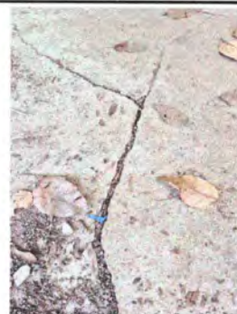
Foto 2: SUSTITUCION LOSA DE PATIO
