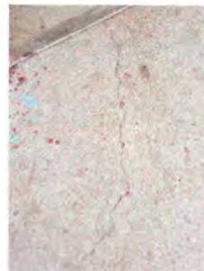
Foto 6: SUSTITUCION DE LOSA DE PATIO
