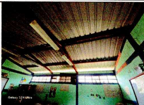
Foto1: Reparación de sistema eléctrico ( ranurado, entubado, cableado, corrección eléctrica, verificación y emplacamiento de luminarias , tomacorrientes polarizados, tierras físicas, instalación de filipones. (6 salones, 1 bodega, 5 baños, 2 pasillos).
