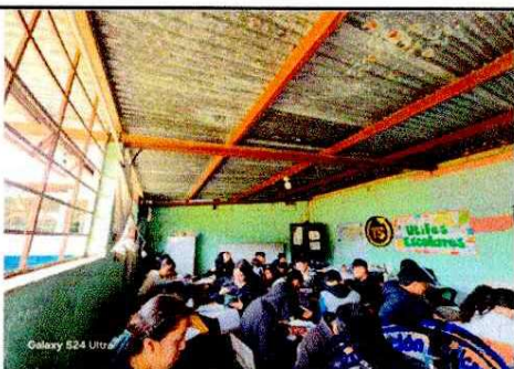
Foto 5: Estructura de techo (Instalaciones de estructura de techo costanera de 6 x2 y 2 x 4) (Instalación de laminas en la sala 26)
