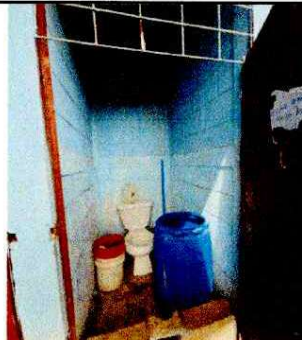
Foto 4: Reparación y mantenimiento de 5 baños y 1 migatorio
