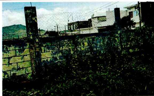
Foto 2: Reparación del muro perimetral con block.
