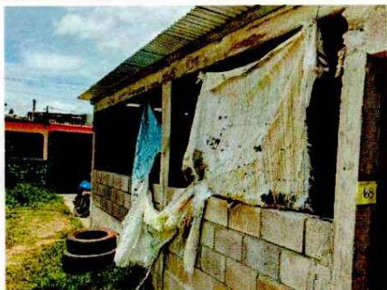
Foto 3: Sustitución de Ventanas.
