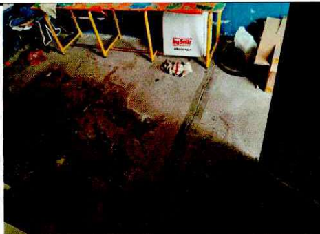
Foto 4: Colocación de piso.
