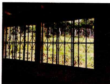
Foto 3: REPARACIÓN DE VENTANAS
