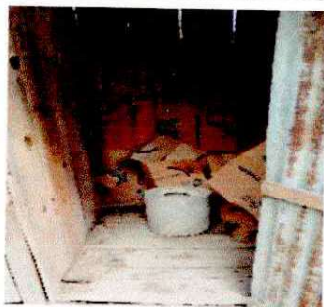
Foto 7: SUSTITUCIÓN DE SERVICIOS SANITARIOS Y SUS ACCESORIOS
