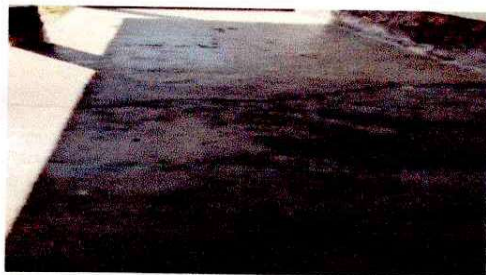
Foto 9: SUSTITUCIÓN DE LOSA DE PATIO
