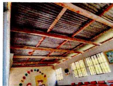
Foto 2: SUSTITUCIÓN DE ESTRUCTURA DE TECHO
