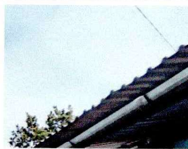
Foto 4: SUSTICIÓN DE CANALES Y BAJADAS DE AGUA PLUVIAL
