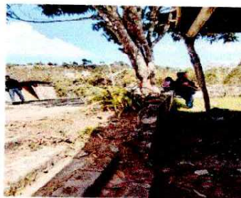
Foto 8: SUSTITUCIÓN DE MURO PERIMETRAL
