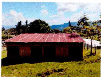
Foto1: SUSTITUCIÓN DE LAMINA
