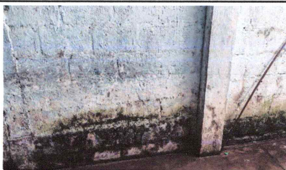
Foto 3: REPARACION DE REPELLO Y CERNIDO DE PAREDES
