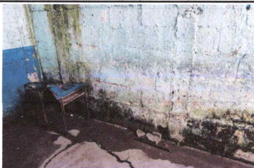
Foto 1: SUSTITUCIÓN MURO PERIMETRAL BLOCK CISADO MAS COLUMNAS DE CONCRETO ESABIETADAS
