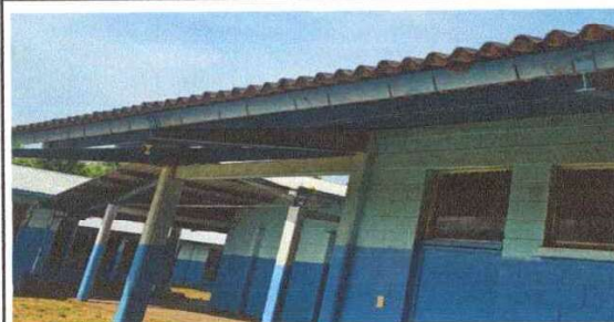
Foto 2: Mantenimiento de estructura del techo por colocación de lámina nueva.
