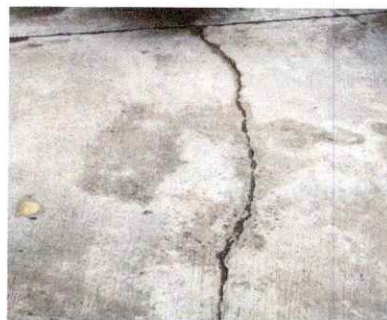
Foto 6: LOSA DE PATIO
