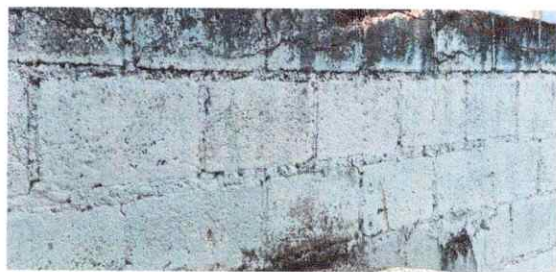
Foto 5: CERCO MURO PERIMETRAL
