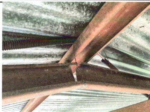
Foto 2: Estructura de techo
