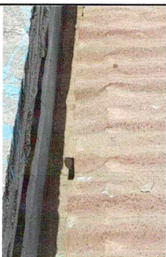
Foto 5: CANALES Y BAJADAS DE AGUA PLUVIAL
