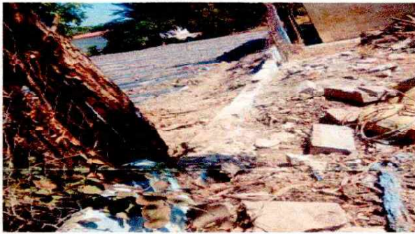
Foto 3: CERCO O MURO PERIMETRAL
