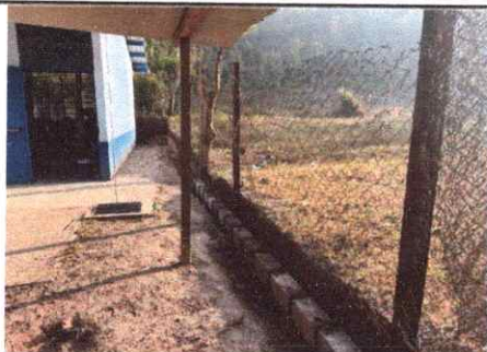
Foto1: SUSTITUCIÓN DE CERCO PERIMETRAL CON BLOCK Y MALLA
