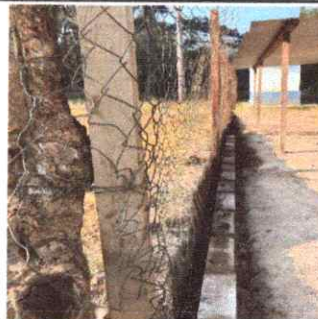
Foto 2: SUSTITUCIÓN DE CERCO PERIMETRAL CON BLOCK Y MALLA
