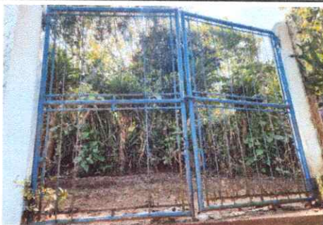
Foto 3: SUSTITUCION DE PORTON DE TUBO CON MALLA (PROMEDIO DE 3X2MTS)
