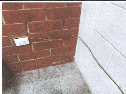
Foto 4: REPARACIÓN DEL SISTEMA ELÉCTRICO, SUSTITUCIÓN DE TOMACORRIENTE
