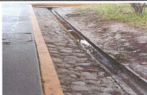
Foto 2: MANTENIMIENTO DE CUNETETA DE CONCRETO
