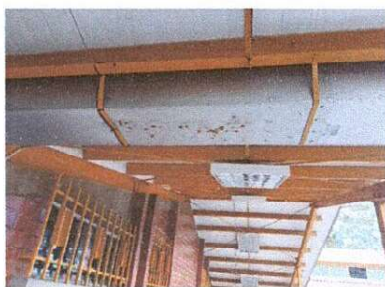
Foto 3: SUSTITUCIÓN DE CANAL DE BAJADA DE AGUAS PLUVIALES
