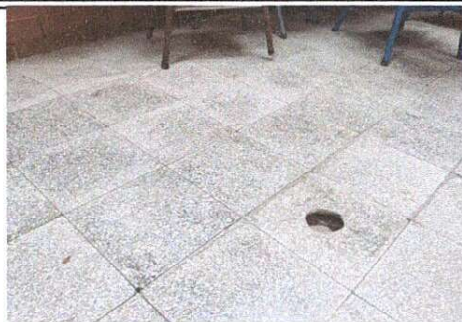
Foto 1: SUSTITUCIÓN DE PISO DE GRANITO
