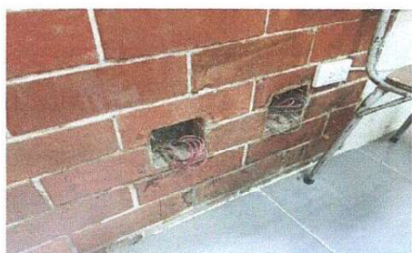
Foto 5: SUSTITUCIÓN DE CABLEADO, CALIBRE 12+DUCTO
