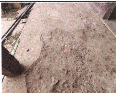
Foto 3: SUSTITUCIÓN LOSA DE PATIO INCLUYE BASE, FUNDICION Y ACABADO
