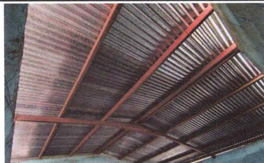
Foto 2: SUSTITUCIÓN ESTRUCTURA DE TECHO
