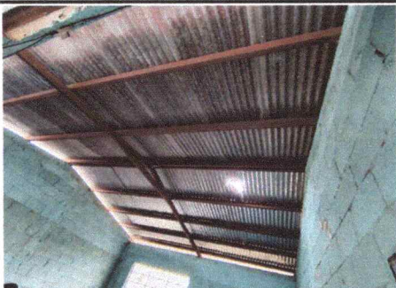
Foto 1: SUSTITUCIÓN LAMINA TROQUELADA CALIBRE 26
