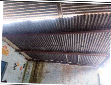
Foto 1: SUSTITUCIÓN LAMINA TROQUELADA CALIBRE 26
