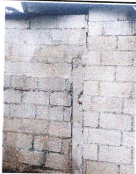
Foto 5: SUSTITUCIÓN MURO PERIMETRAL BLOCK CISADO MAS COLUMNAS DE CONCRETO ESABETADAS
