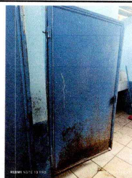
Foto 2: Sustrución y mantenimiento a puertas de baños.
