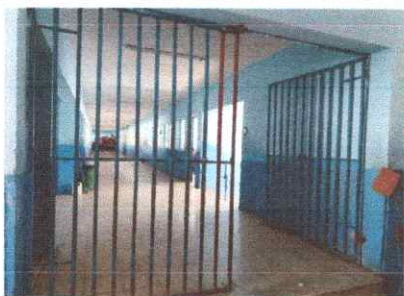
Foto 3: Reparación y mantenimiento de puertas de barranda
