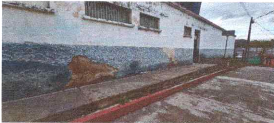
Foto 1: REPARACION DE REPELLO Y CERNIDO DE PAREDES
