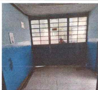
Foto 5: Reparación y mantenimiento a porton (chapa yale)
