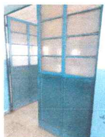
Foto 6: Reparación y mantenimiento portones
