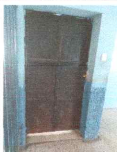
Foto 2: Reparación y mantenimiento de puertas de aulas (chapa yale)
