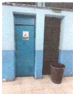
Foto 1: Sustrucción puertas de aulas (2*1mts)
