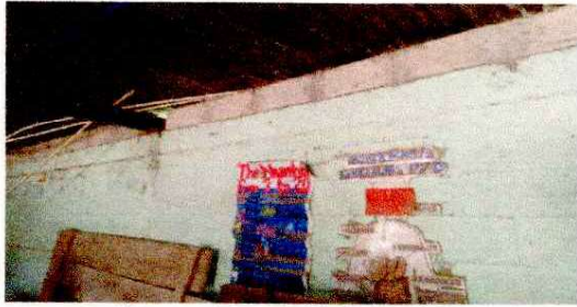
Sustitución de pintura a base de agua.
