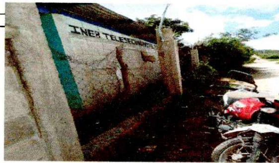
Foto 6: Sustitución de muro de Block pineado
