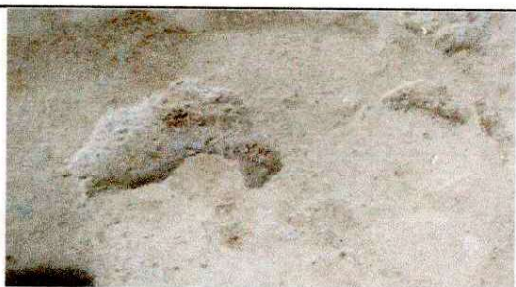
Reparación de piso de cemento fundicion más alizado
