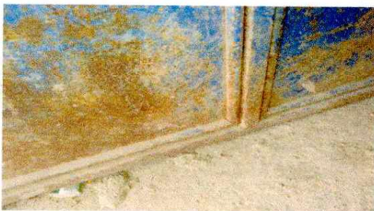
Reparación y Mantenimiento de puertas en área de aula
