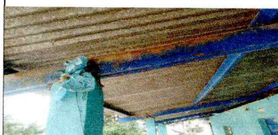
Reparación y Mantenimiento de estructura de techo
