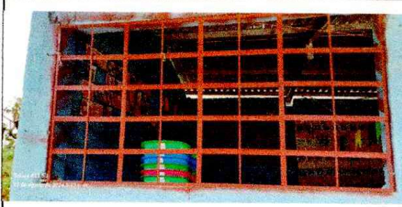
Sustitución de ventanas.
