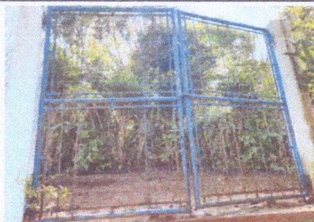
Foto 2: SUSTITUCION DE PORTÓN DE TUBO CON LAMINA LISA (4X5MTS)
