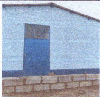
Foto 3: PINTURA EN MUROS INTERIOR Y EXTERIOR
