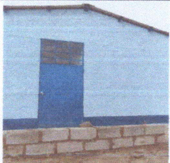
Foto 1: SUSTITUCIÓN MURO PERIMETRAL BLOCK CISADO MAS COLUMNAS DE CONCRETO ESABIETADAS
