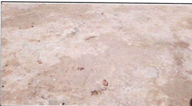
Foto 4: LOSA DE PATIO
