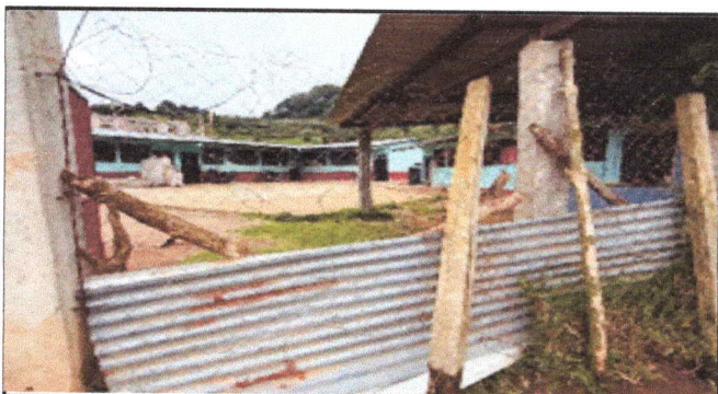
Foto 3: CERCO O MURO PERIMETRAL
