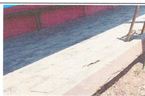
Foto 6: Reparación de piso de granito.
