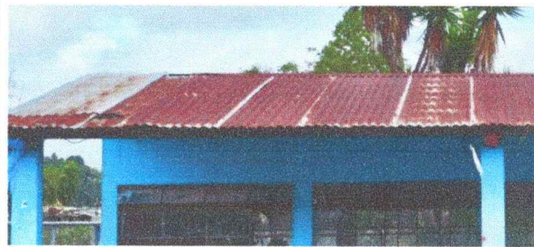
Foto 2: Cambio de lámina por mal estado.
