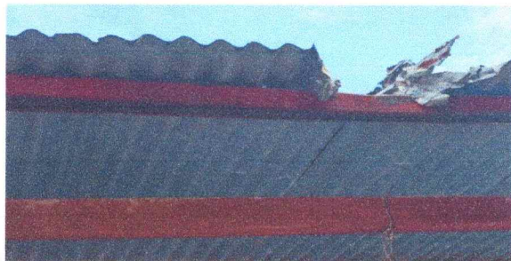
Foto 3: Mantenimiento de estructura de techo.
