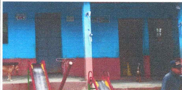
Foto 4: Reparación de puertas.
