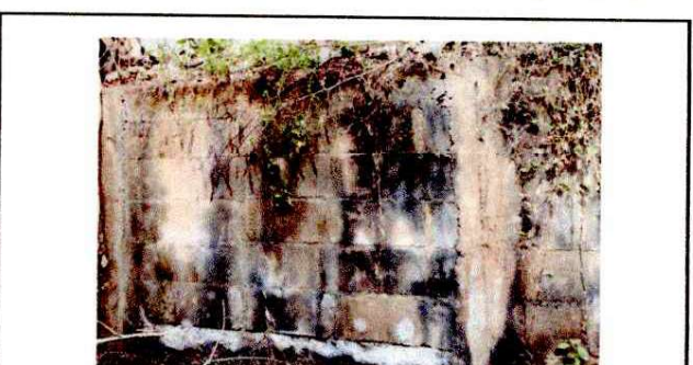
Foto 6: Sustitución de muro perimetral.
