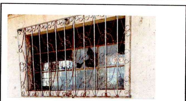
Foto 4: Sustitución de ventanas.
