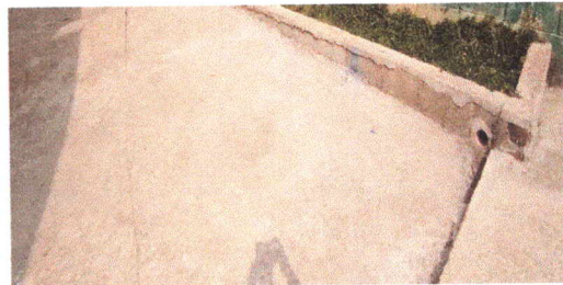
Foto 4: LOSA DE PATIO
