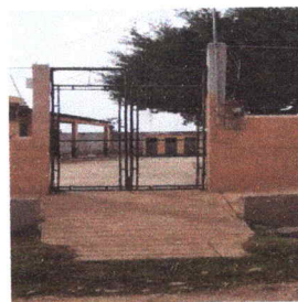
Foto 2: MANTENIMIENTO DE PORTONES
