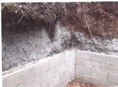
Foto 5: REPARACION DE MUROS DE CONTENCIÓN
