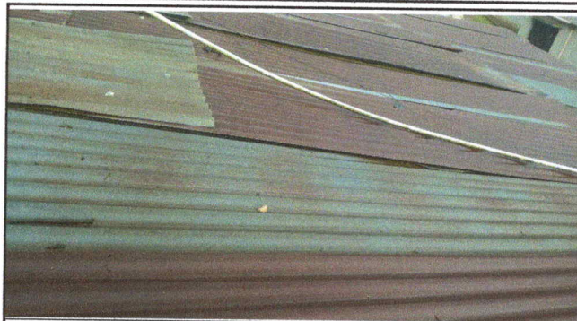
Foto 2: CUBIERTA DE LAINA A SUSTITUIR
