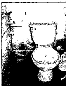
Foto 3: SUSTITUCIÓN DE SANITARIO COMPLETO (INCLUYE CONTRALLAVE)
