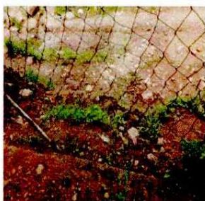
Foto 1: CERCO O MURO PERIMETRAL
