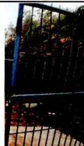
Foto 2: MANTENIMIENTO A PORTONES
