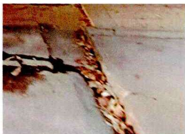
Foto 3: LOSA DE PATIO
