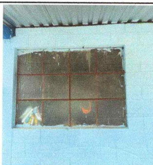
Foto 5: SUSTITUCIÓN DE VENTANAS
