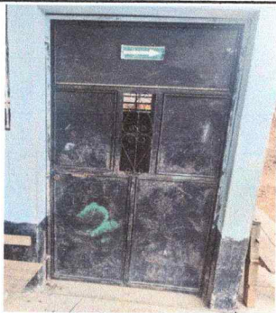
Foto 1: SUSTITUCIÓN PUERTAS EN AREA DE AULAS
