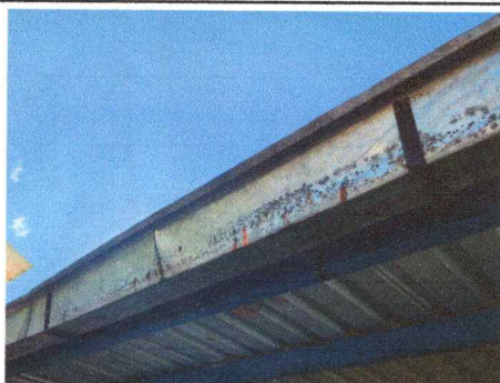
Foto 3: SUSTITUCIÓN DE CANALES Y BAJADAS 4"
