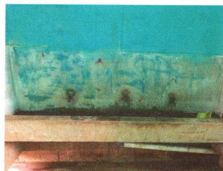
Foto 4: SUSTITUCION DE AZULEJO
