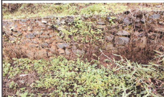
Sustitucion de gaviones
