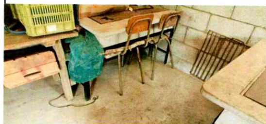
Foto 2: Reparación general de la cocina para ser habilitada.
