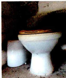
Foto 7: SUSTITUCION DE SANITARIO COMPLETO INCLUYE CONTRA LLAVE Y SUSTITUCION DE ACCESORIOS INTERNOS.
