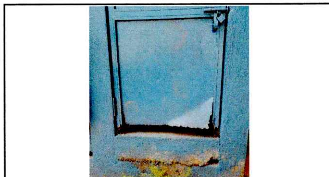
Foto 3: SUSTITUCION DE PUERTAS EN AREA DE AULAS Y BAÑOS
