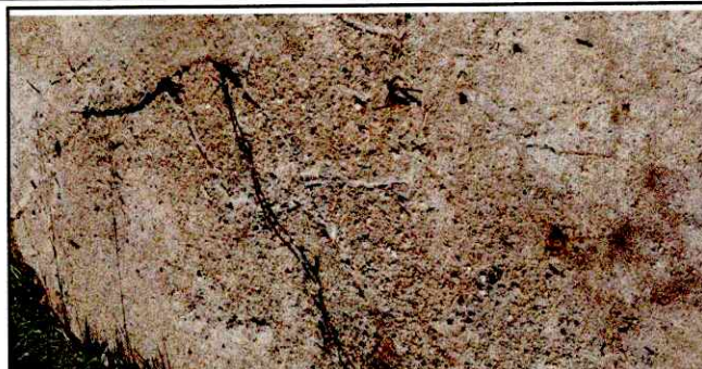
Foto 8: SUSTITUCION LOSA DE PATIO INCLUYE BASE FUNDICION Y ACABADO.
