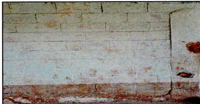
Foto 6: SUSTITUCION DE PINTURA BASE AGUA Y ACEITE
