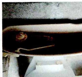
Foto 7: SUSTITUCION DE SANITARIO COMPLETO INCLUYE CONTRA LLAVE Y SUSTITUCION DE ACCESORIOS INTERNOS.
