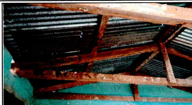
Foto 1: SUSTITUCION LAMINA TROQUELADA CALIBRE 26
