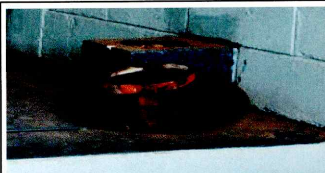
Foto 10: SUSTITUCION DE CHIMENEA
