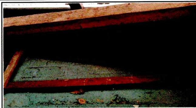
Foto 2: SUSTITUCION ESTRUCTURA DE TECHO
