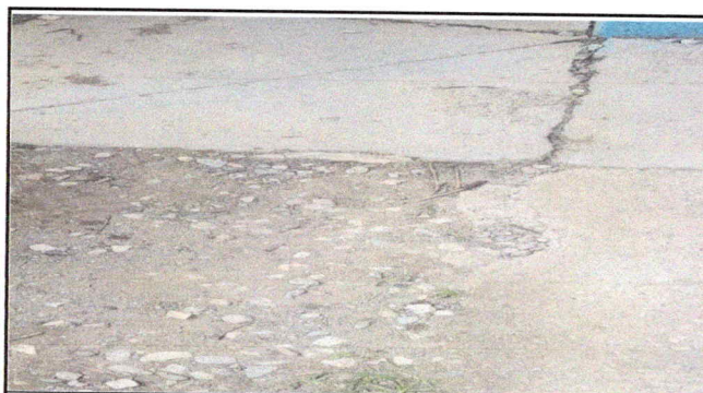
Foto 4: LOSA DE PATIO EN MAL ESTADO
