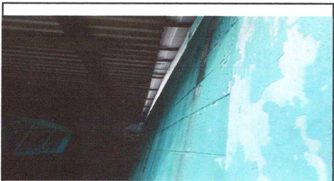
Foto 4: Reposición de canales
