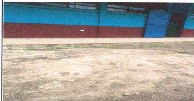
Foto 2: Reparación y construcción de losa patio
