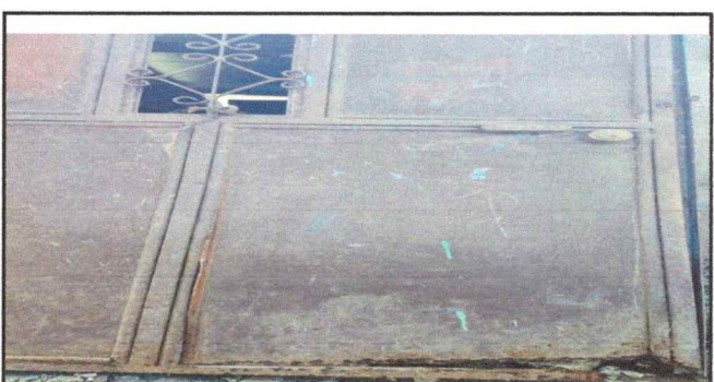
Foto 6: Cambio de Puertas
