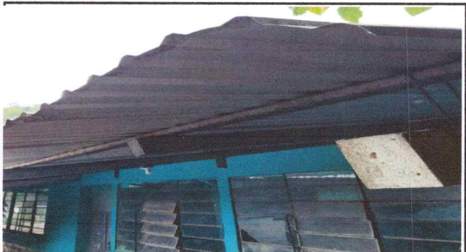
Foto 3: Cambio de techo lamina troquelada
