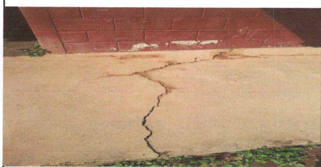
Foto1: Cambio de losa corredor del aula
