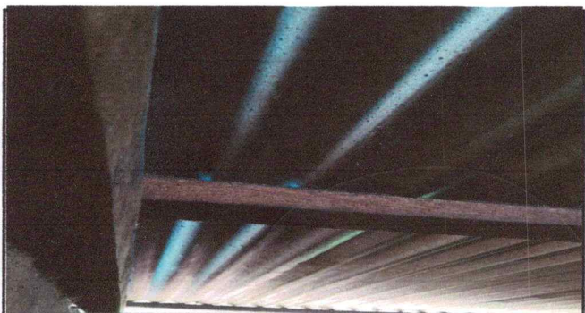
Foto 5: Cambio de costanera madera podrida por metalica.
