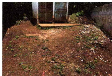
Foto 4: DRENAJE Y FOSA SEPTICA
