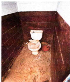
Foto 3: Sustitución de baños y pintura de baños
